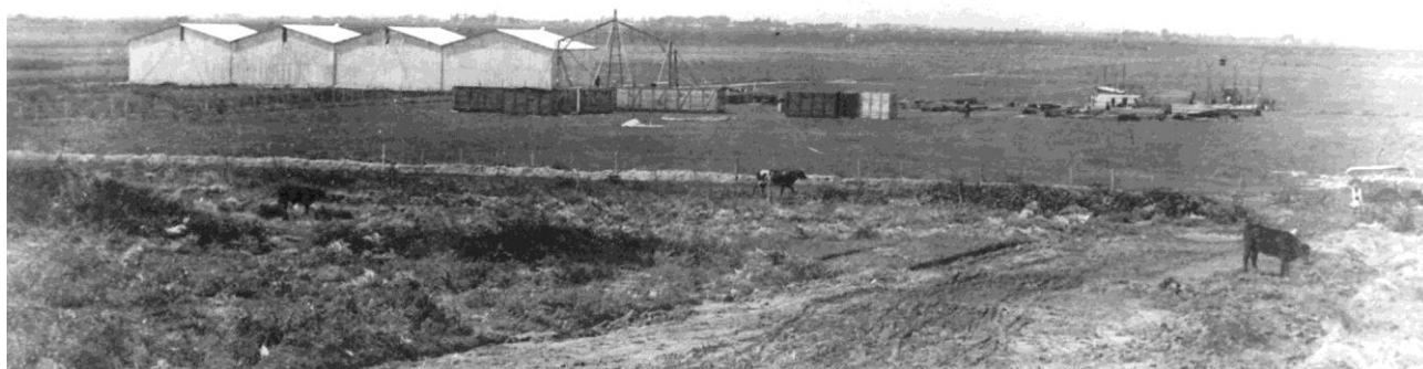
Vista de los cuatro hangares en construidos en Villa Lugano. La fotografía está tomada en marzo de 1910 prácticamente desde la esquina de Av. Coronel Roca y Tellier 33 . En 1912 esos cuatro hangares fueron trasladados al aeródromo militar El Palomar donde se establecieron el Aero Club Argentino y la Escuela de Aviación Militar
